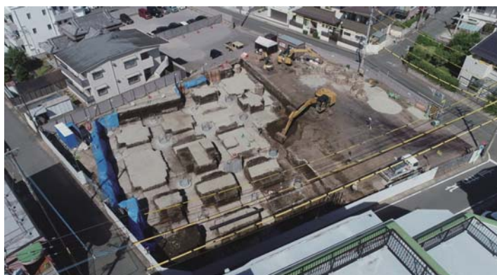
【基礎工事の様子 2022年10月3日撮影】
